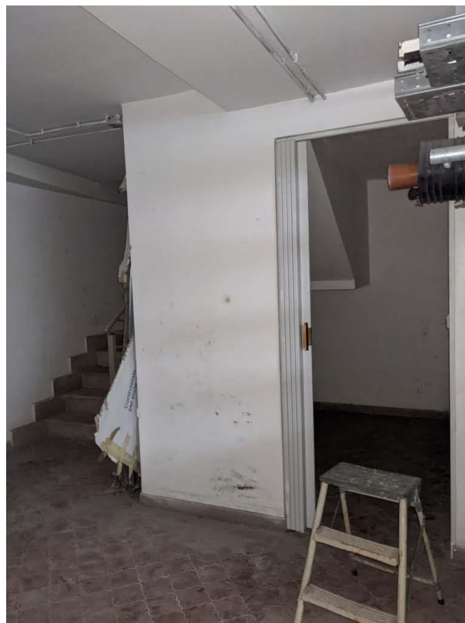
Vista del locale di servizio sottoscala al piano interrato
