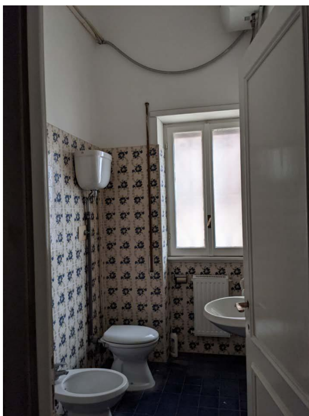
Vista del locale igienico
