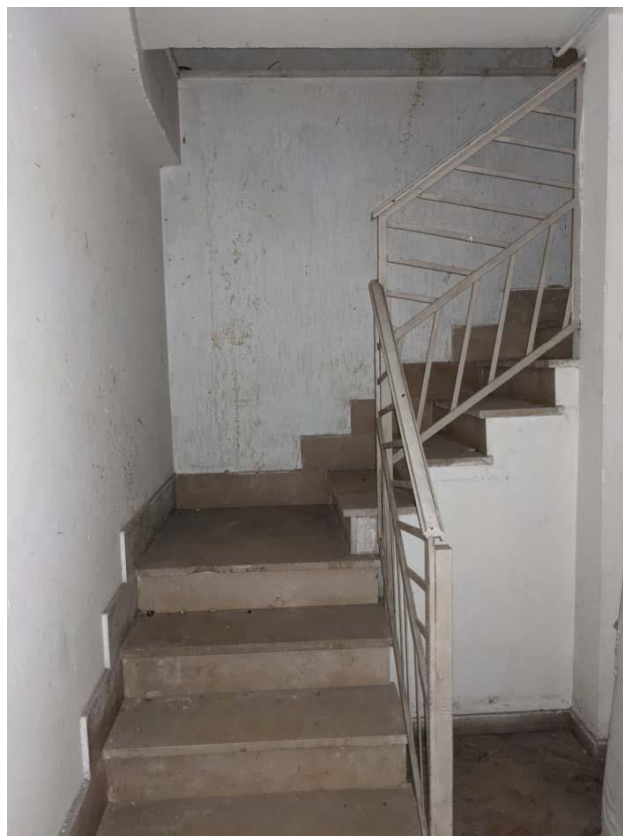
Vista del vano scala interno
